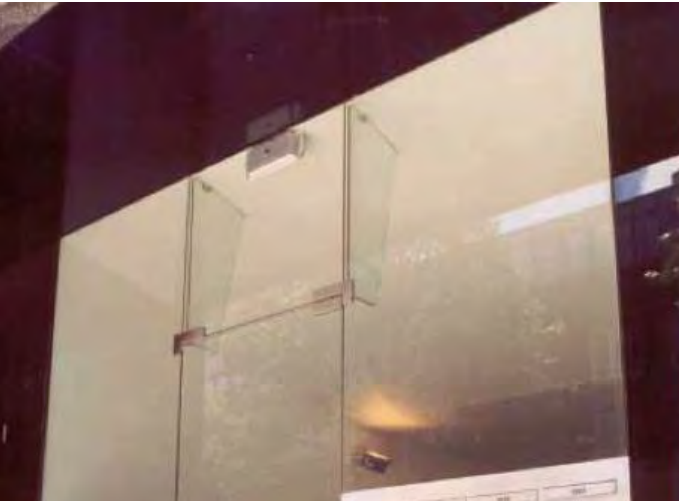
glaspuien entree, vergaderzaal en ontmoetingsruimte: Totalglas Metaglas (bij vergaderzaal geluidsisolerend ) voorzien van privacyfolie
